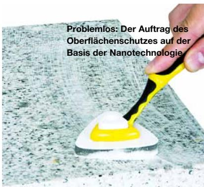
**Problemlos: Der Auftrag des Oberflächenschutzes auf der Basis der Nanotechnologie**
