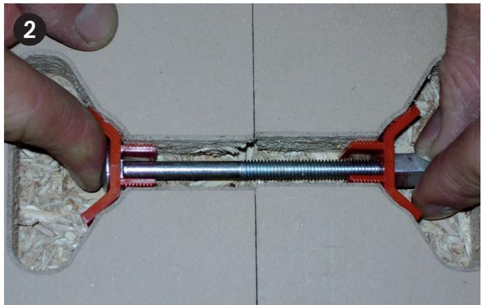
Der Verbinder sitzt absolut fest in den Nuten, passt genau und verrückt oder verschiebt sich nicht mehr. Er muss nicht mehr festgehalten werden und kann nicht herausfallen. Jetzt haben Sie für alle weiteren Arbeiten beide Hände frei.
