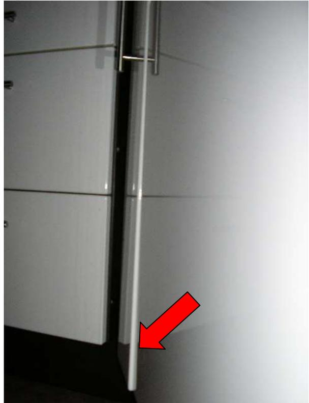
Bild 06 und 07 - zu groß dimensionierter und zu tief eingebauter Schub für Backbleche
