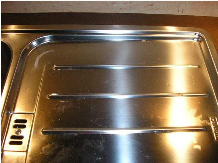
Bild 17 – Extreme Wasserflecken nach Betätigen des Wasserhahns und fehlende Glasplatte
