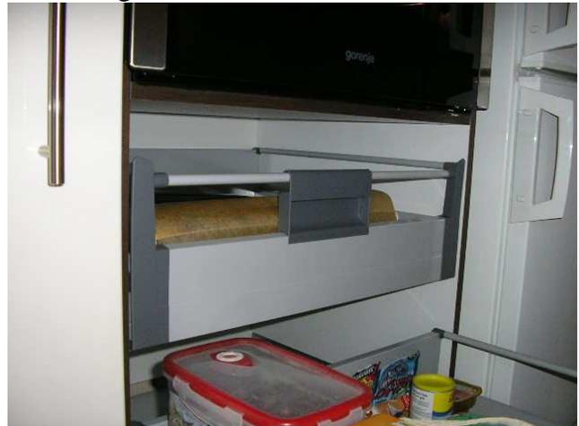
Bild 08 – nun zu beengte Kochfeldecke; man stößt beim Kochen ständig mit Ellbogen gegen Hochschrank mit Backofen; zurückzuführen auf Fehlplanung, weswegen Unterschrank mit Kochfeld weiter rechts positioniert werden musste und dem zu schmalen Apothekerunterschrank, weswegen Hochschrank zu nah steht
