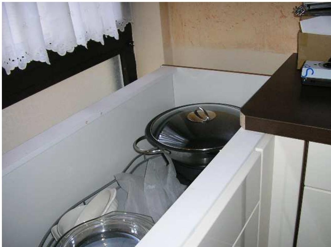
Bild 11 – fehlende Arbeitsplatte für Topfschrank; vorgesehener Schub konnte nicht eingebaut werden, da ansonsten oberes Deck des Topfkarussells nahezu nicht mehr nutzbar wäre; zusätzlich die fehlende Steckdosenlösung, welche wegen der fehlenden Arbeitsplatte nicht eingebaut werden konnte
