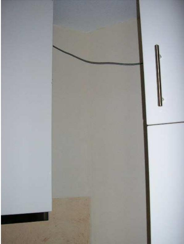
Bild 19 – fehlende Sockelleisten
