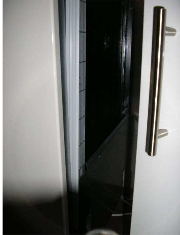
Bild 14 – Spülmaschine, die nicht „eingekleidet“ ist
