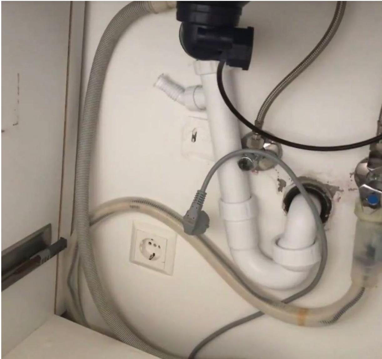
**Lösung Mangel 10:** Wasserabpumpschläuche und Verbindungen so montieren, dass das Wasserabpumpen nicht allzu laut ist.
