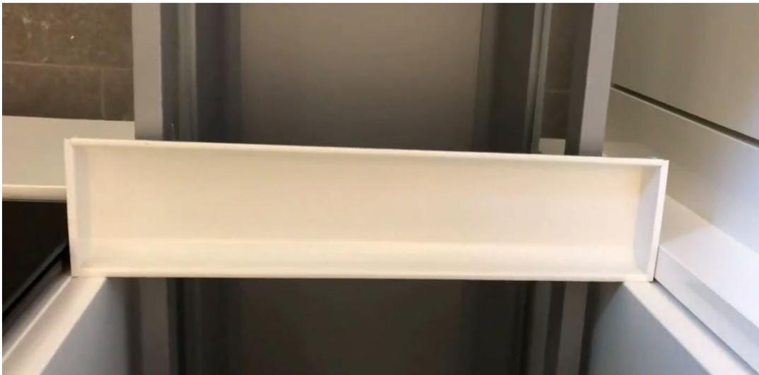
**Lösung Mangel 12: Schubladenteile fertig montieren.**
