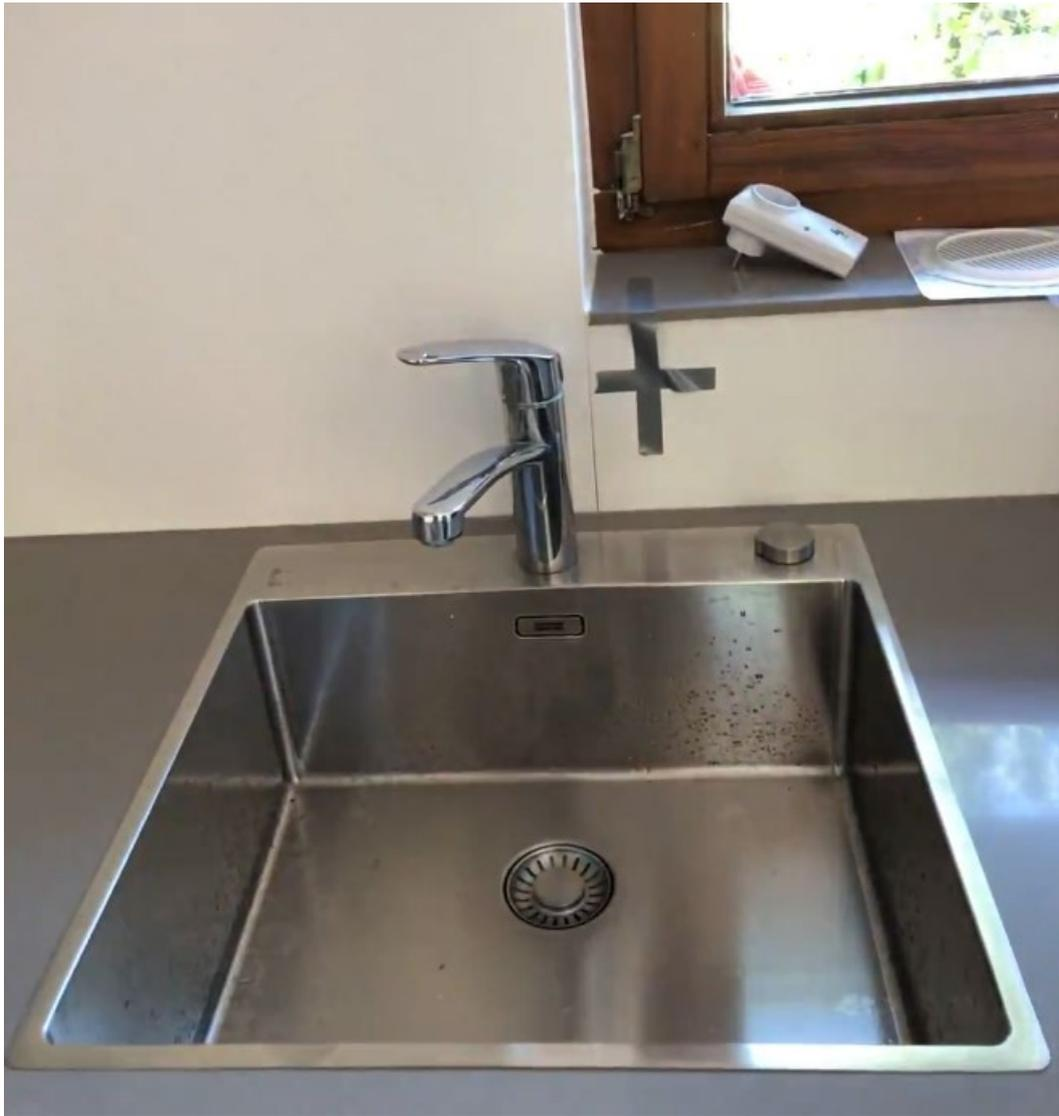
**Lösung Mangel 6:** Nischenplatten fach- und sachgerecht an einem Stück hinter ohne Stoß oder Fuge dem hinter dem Wasserhahn anbringen
